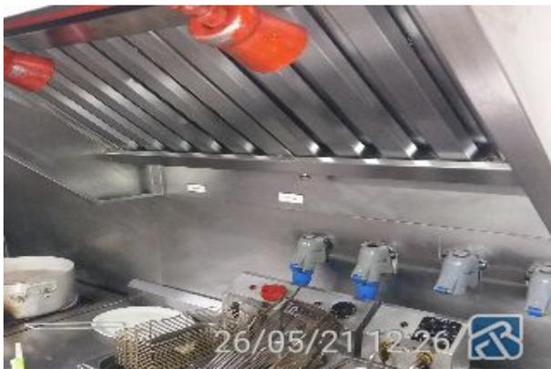
Recomendamos que seja revisado as tomadas elétricas do fluxo de cocção. De acordo com a NBR 14.518 item 5.5.3.2, as tomadas elétricas devem ser instaladas fora do fluxo gasoso proveniente dos equipamentos de cocção. [R1]
