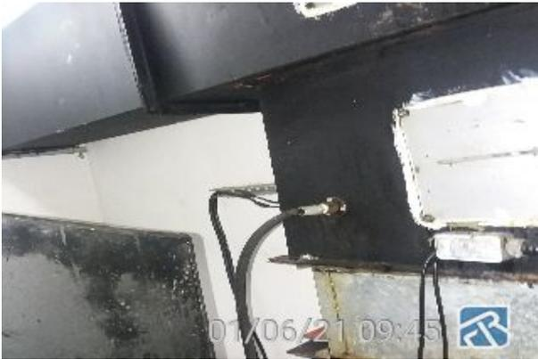
Isolar Duto. Em caso de incêndio nos dutos a calor irradiada é intensa e acabaria incendiando objetos encostados ou próximo dos mesmos. Recomendamos com Fibra cerâmica com manta aluminizada(Kaowool), com densidade 96KG/M3, DIMENSÃO 7620 X 610 X 25,40 e temperatura 880 c (sf) spun ou outros similares. NBR 14518 item-5.5.4.2 [R2]
