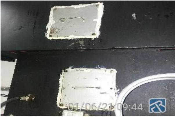
inspeção devem ter material resistente(chapa bitola 16) e serem instaladas fora do fluxo com colarinho de 0,10m soldados no duto e flangeados na outra ponta. As portas fixadas com parafusos ou porcas do tipo volante. NBR 14518 Item-5.2.3.1
