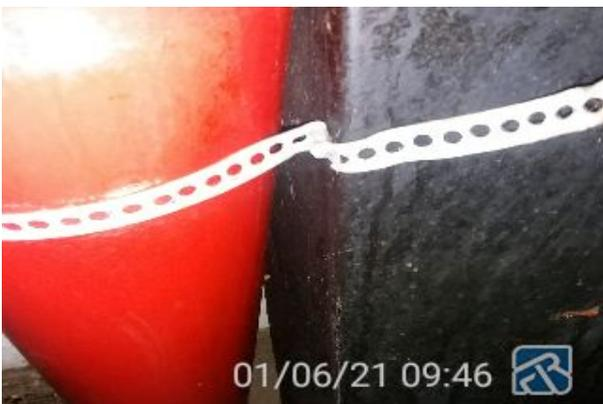
Cilindro fixado no duto. O mesmo deve ser fixado na parede.
