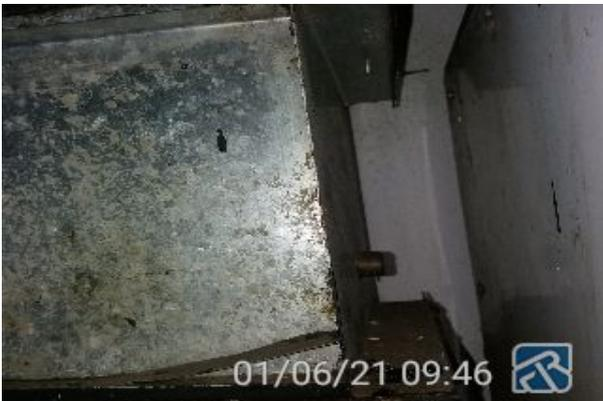
Junções visualizadas na casa de máquinas estão inadequadas. Fixadas com parafusos auto brocante.
