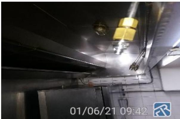
\*Importante desobstruir ou efetuar limpeza nos bicos dos difusores \*\*e implantar tampa/cap nos bicos dos difusores saponificantes, a fim de que estes não sejam obstruídos pela cocção/gordura que é gerada sob a coifa. Por impedir o entupimento dos bicos, o agente será despejado livremente no local destinado. OBS.: Manter o cap sempre plugado corretamente no bico. [R2]
