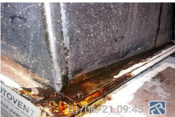
Sanar vazamento de gordura no duto(Leve). Efetuar limpeza nos dutos. Importante procedimento que deve ser executado sempre que fique próximo a 2mm a camada de espessura de resíduos incrustados. Limite máximo tolerável 6mm. NBR 14518 observar Item 6 até 6.3.6 [R1]
