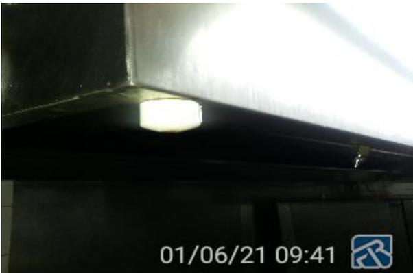
Coifa com dreno em PVC. Recomendamos instalar tampão em metal no dreno, a fim de que não haja vazamento de gordura/cocção no equipamento. NBR 14.518 Item 5.1.3.2 [R1]
