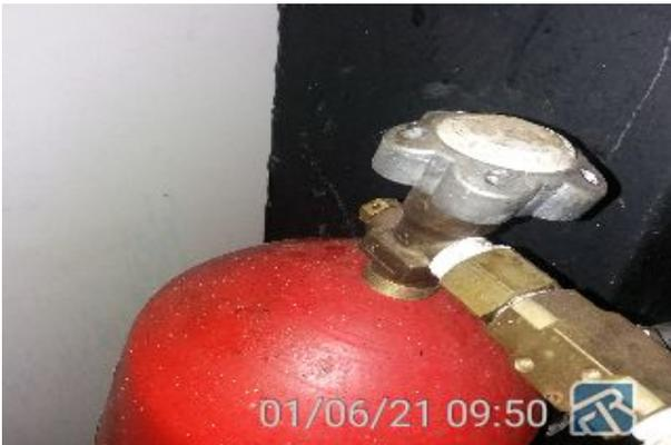
Recomendamos que seja retirado registro de bloqueio manual do sistema, pois deve ser projetado de forma que não haja a possibilidade de descontinuidade na disponibilidade de gás. NBR 12.232 Item 5.2.6 / Todas as válvulas que controlam a liberação e a distribuição de CO2 devem ser providas de dispositivo manual para acionamento de emergência do sistema. Os dispositivos devem ser, de preferência, de acionamento mecânico. NBR 12.232 Item 5.3.2.2
