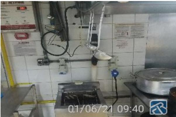
Equipamento deve ser balanceado adequadamente sob a coifa. Seguir NBR 14.518 Item 5.1.4, onde define que os equipamentos devem estar balanceados a 15cm de distância nos lados livres e a altura entre a base do captor e a superfície da cocção não deva ser superior a 1,20m. [R1]
