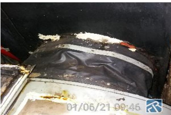
Especificar lona de junta no duto. A lona anti-chama aplicada deve ter o tempo requerido de resistência ao fogo (TRRF) de 1 h de operação a 400°C. NBR 14.518 Item 8.1 [R1]
